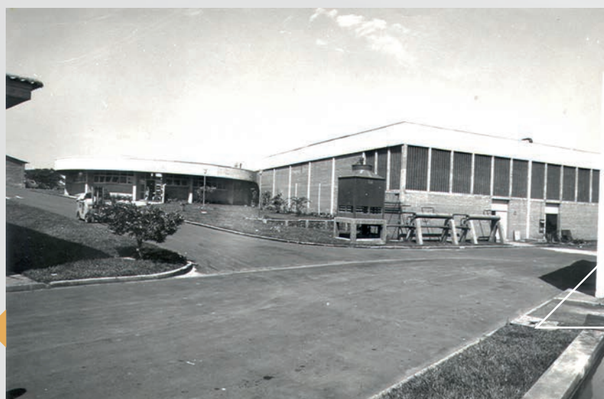
Vista parcial do prédio do CTC.
