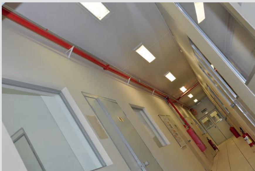
Adequações realizadas no Itai para obtenção do AVCB.
