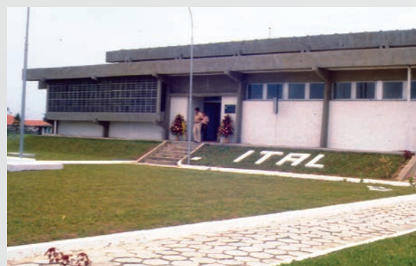
Vista parcial da Usina-Piloto de Pescado e Recursos Marinhos do Itai, na cidade do Guarujá.
