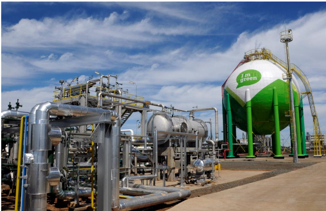
FIGURA 2. Complexo industrial de Triunfo com a esfera onde é armazenado o eteno verde.
