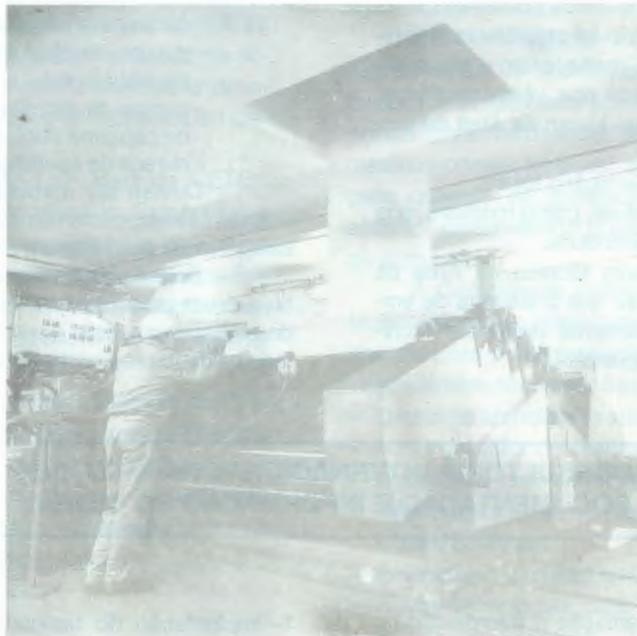
A instalação inaugurada em 9 de novembro passado admite folhas de aço de espessura compreendida entre 0,15 e 0,65mm, destinadas à fabricação de corpos de latas embutidas e de fundos. Provisoriamente, sua velocidade se situa ao redor de 180m/min, limiar que será logo superado, enquanto a largura útil, atualmente compreendida entre 600 e 975mm, chegará a 1300mm num futuro próximo.
