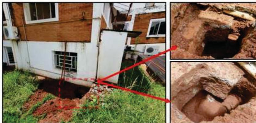
Figura 9 – Detalhamento de ponto escolhidos para a prospecção da fundação do imóvel objeto.
