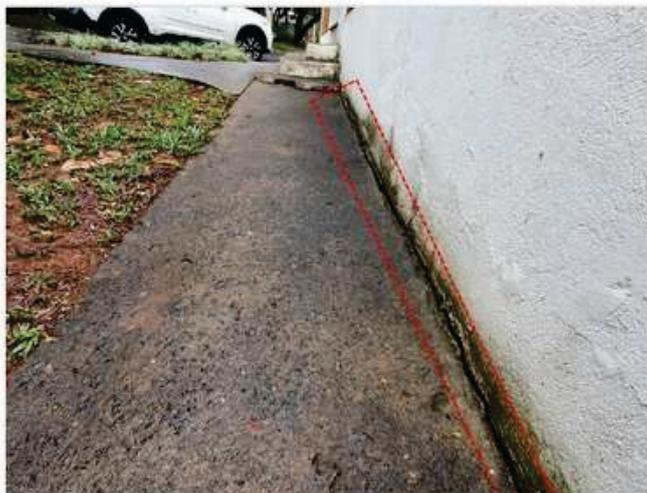
Figura 17 – Detalhe da trinca/abertura entre a calçada e parede externa.
