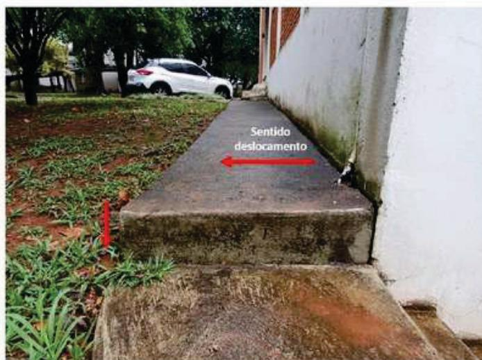
Figura 16 – Detalhe da abertura e deslocamento da calçada externa.
