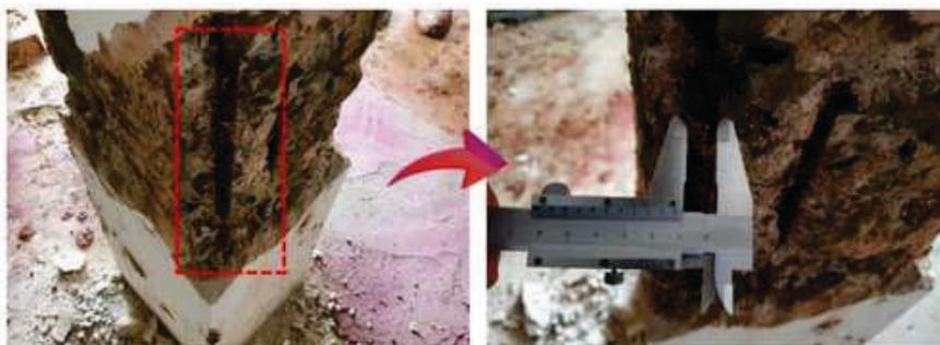
Figura 21 – Detalhe do processo corrosivo na armadura e verificação in loco.
