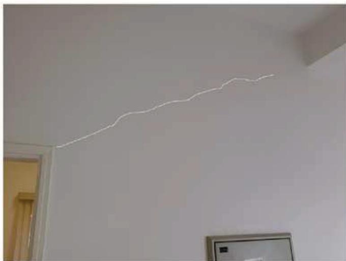
Figura 15 – Destaque das trincas na alvenaria situadas no corredor de acesso.
