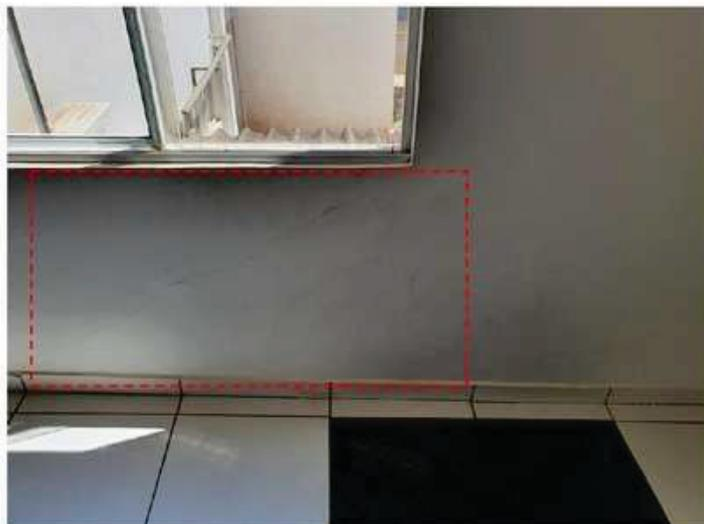
Figura 13 – Detalhe da trinca (destaque em vermelho) a 45° no corredor do pavimento térreo.
