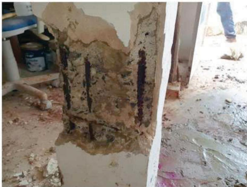
Figura 22 – Vista de pilar degradado, com armadura em processo corrosivo e perda significativa de cobrimento.
