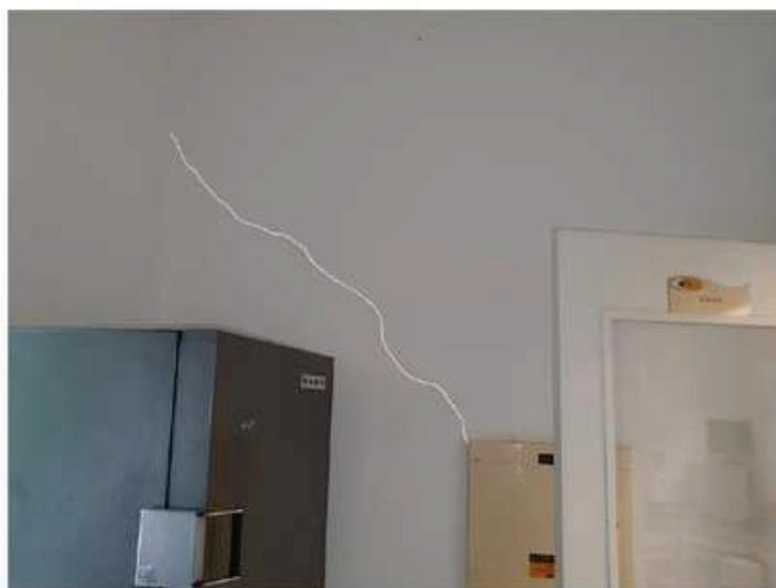
Figura 14 – Trinca em destaque observada no imóvel objeto.
