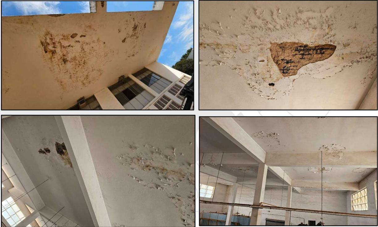
**Imagens de vistoria realizada em 14/08/2024 nos locais de execução dos serviços que mostram as superfícies inferiores das lajes deterioradas.**
