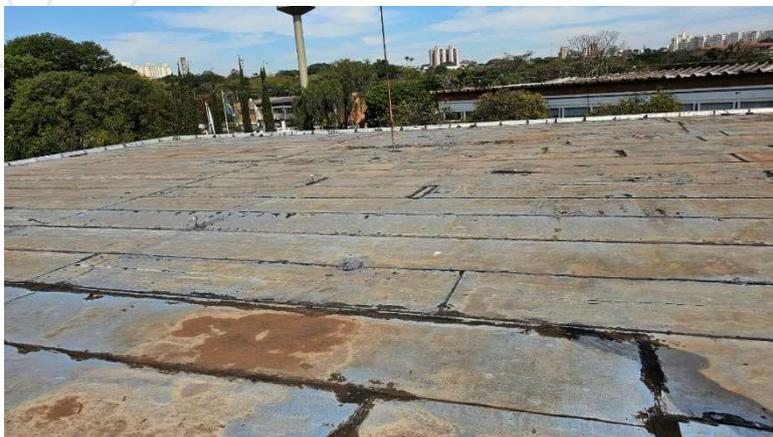
**Imagens de vistoria realizada em 14/08/2024 nos locais de execução dos serviços que mostram as condições atuais deficitária do sistema de impermeabilização das lajes existentes.**
